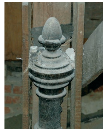
Detail im historischen Treppenhaus
