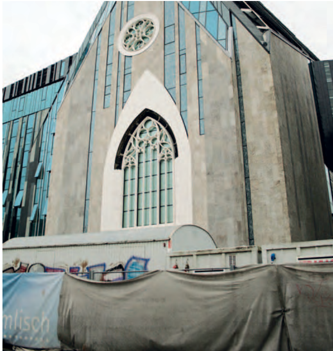
Immer noch eine Baustelle: das Paulinum
