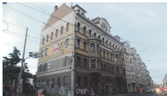
Streitobjekt im Waldstraßenviertel: Haussanierung Foto: bw
